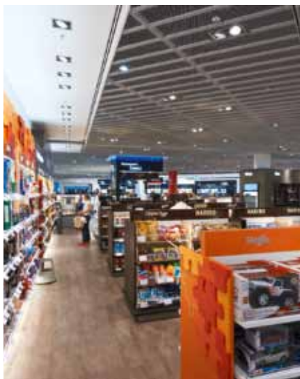
Attraverso guide a fessura, l'aria condizionata viene immessa nelle aree commerciali senza creare correnti.
