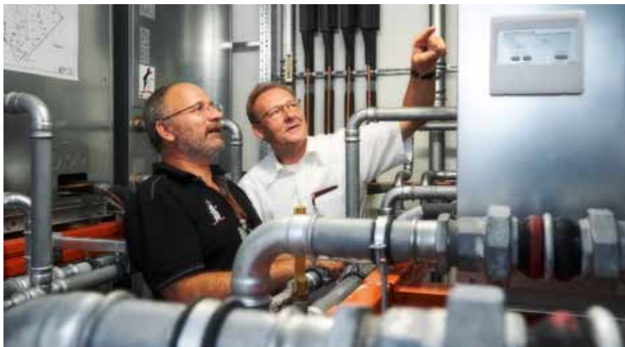
Rolf Wiesinger (W+W Kälte- und Klimaanlagebau GmbH) e Thomas Schmidt (Mitsubishi Electric Frankfurt) durante una verifica del primo impianto pronto ad entrare in funzione.
