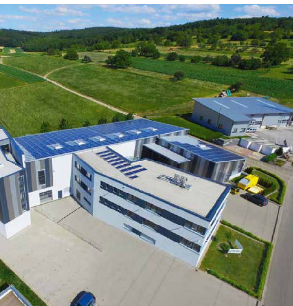
Drohnenaufnahmen von einem Teil des Firmengebäudes der PREMEX GmbH
