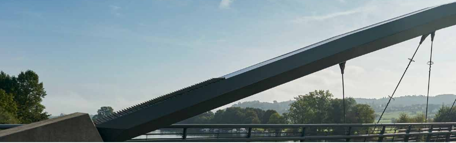
Die im Jahr 1997 fertiggestellte Brücke führt über die Aare und verbindet die Kantone Bern und Solothurn.
