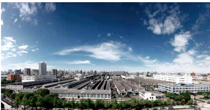
Das Zentrum für die Produktion von Erodiermaschinen ist das Werk Nagoya. Es wurde im Jahr 1924 drei Jahre nach der Gründung der Mitsubishi Electric Corporation eingerichtet.
